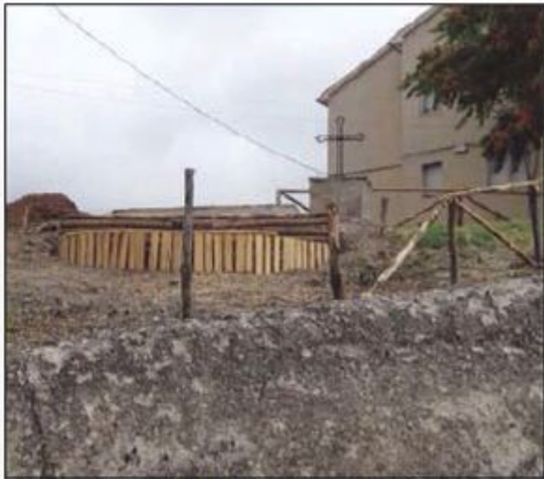
Il luogo ristrutturato dall'Auser
